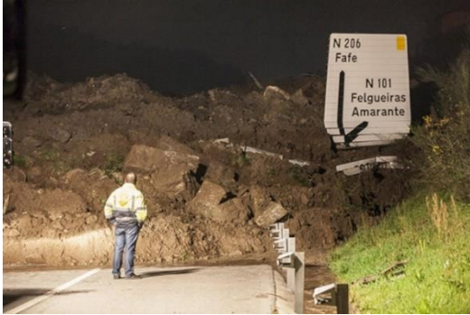
Figura 3: Obstrução da via rápida como resultado do movimento em massa.
