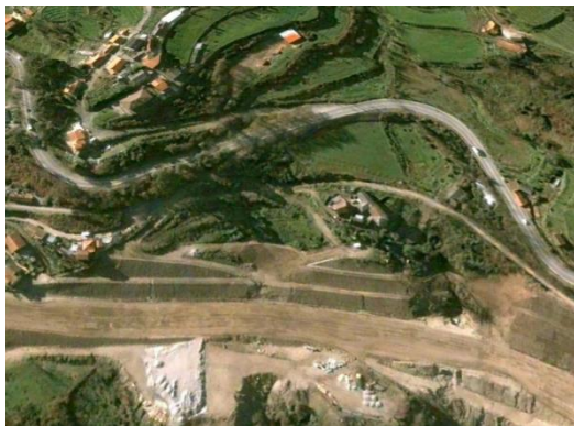
Figura 4: Abertura de talude para a construção da via rápida, 2004.
